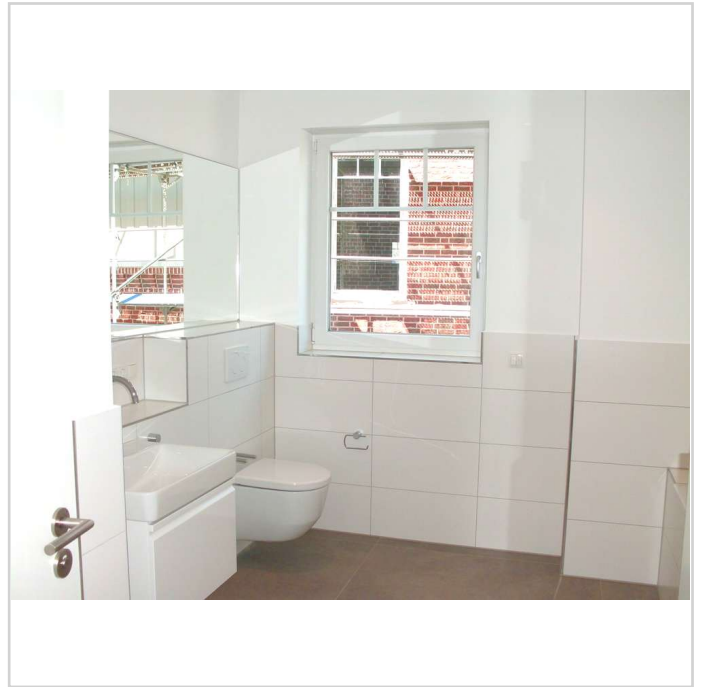
Modernes Bad mit Fenster
