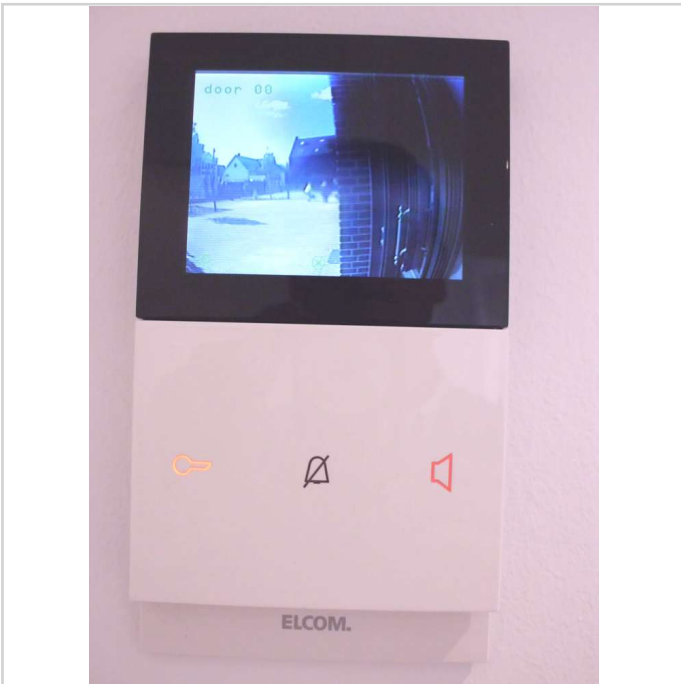
Videosprechanlage am Eingang
