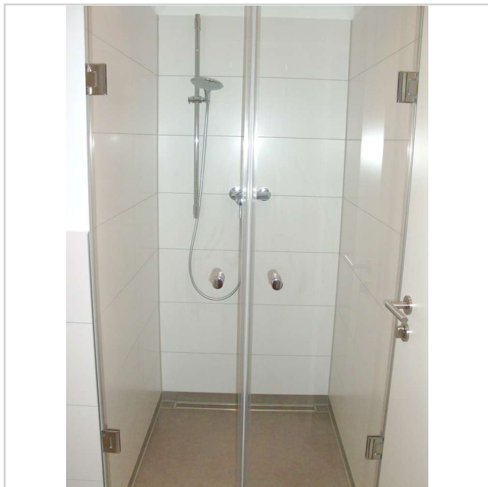
bodengleiche Dusche im Bad
