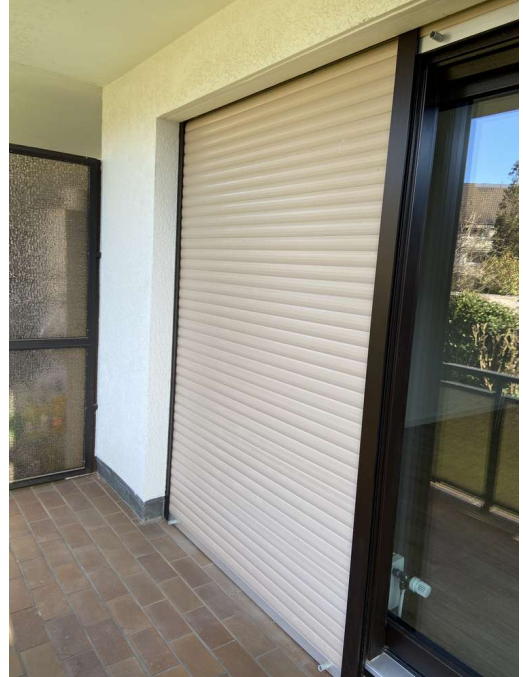
Loggia-Fenster mit Rollladen
