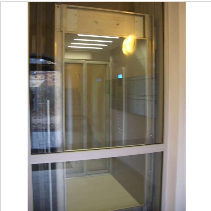
Moderner Aufzug aus Glas
