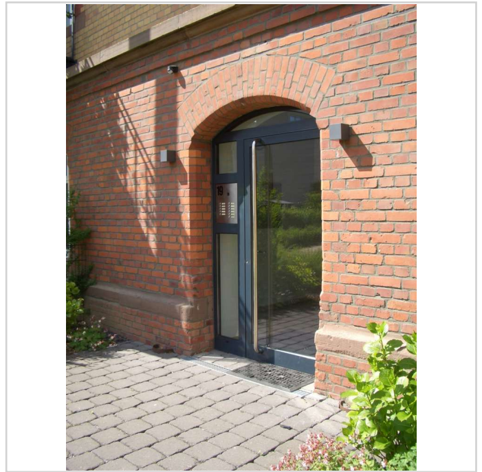
Der Hauseingang Nr. 19
